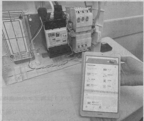
分電盤内に設置された電力センサーを活用し、家電の使用状況をネット上で把握できる
